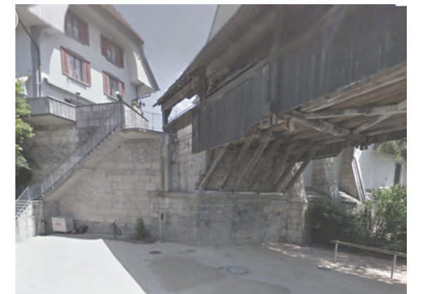
Bereich Stadtplatz Nr. 62 mit Brückenkopf
