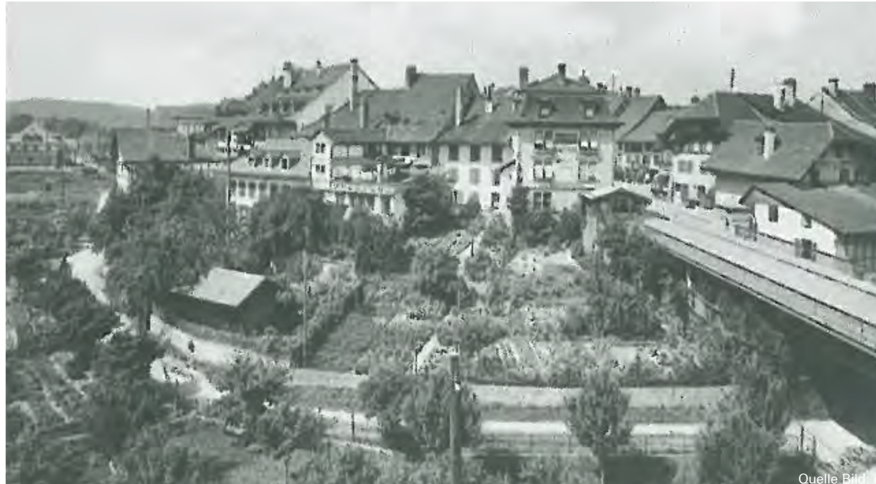
Falkenbrücke, Ansicht stadtplatzabgewandte Seite, um 1940-1950
